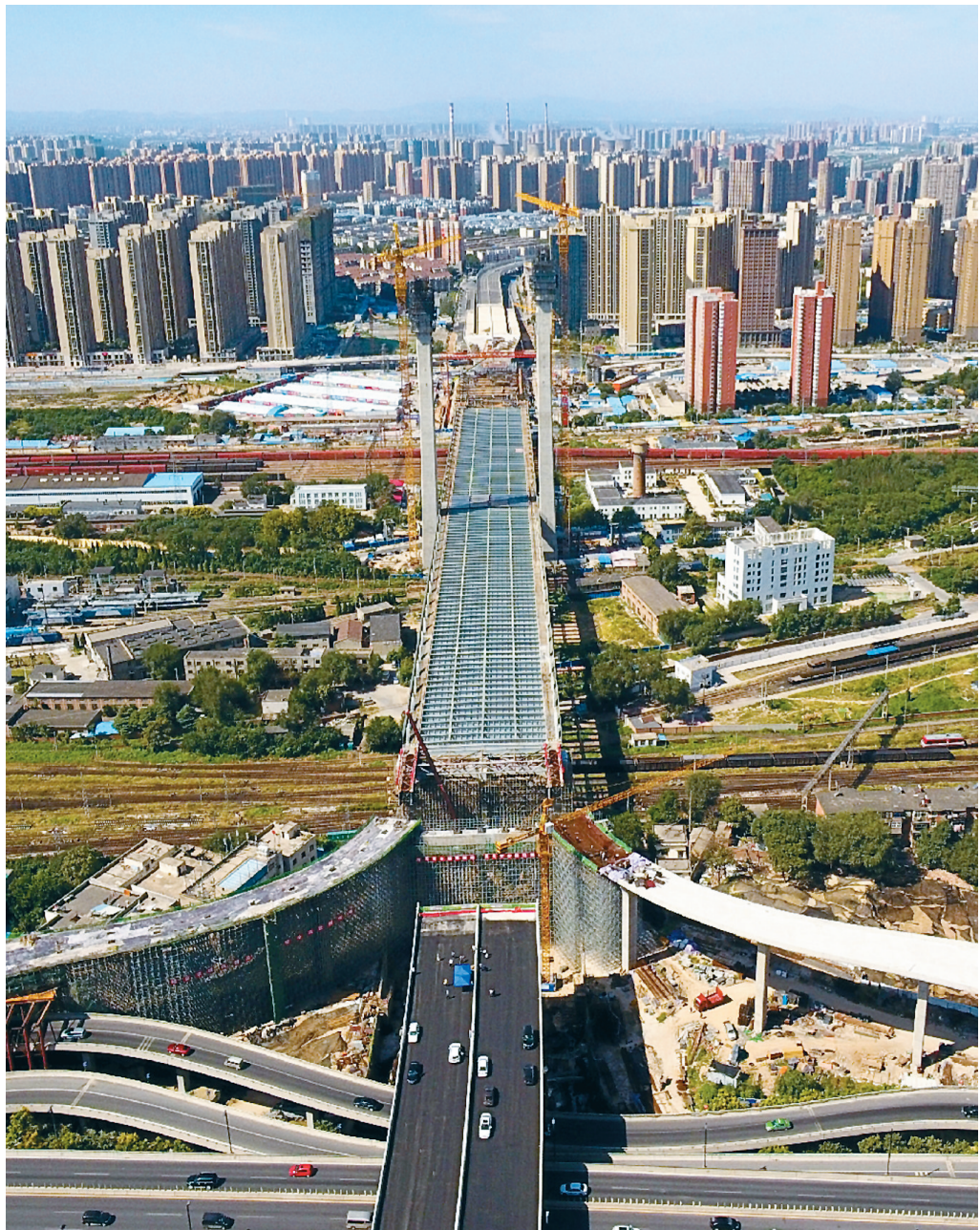
昨日上午10时30分,郑北大桥钢梁全部顶推到位
