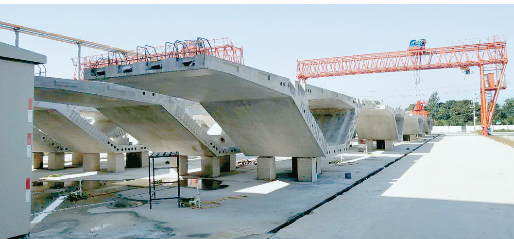
预制梁制造现场
