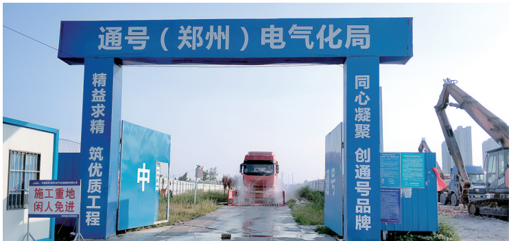
严控工地扬尘
