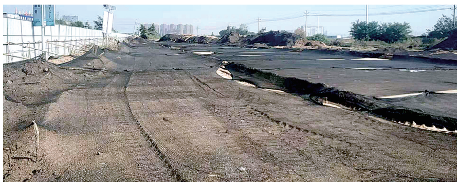
对黄土裸露的地面覆盖防尘网
