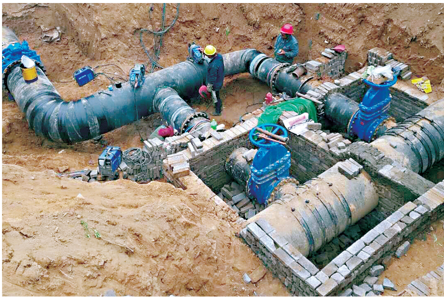
施工人员抓紧施工
