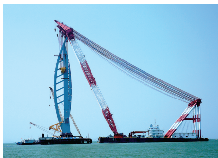
首个“海豚”塔成功吊装
