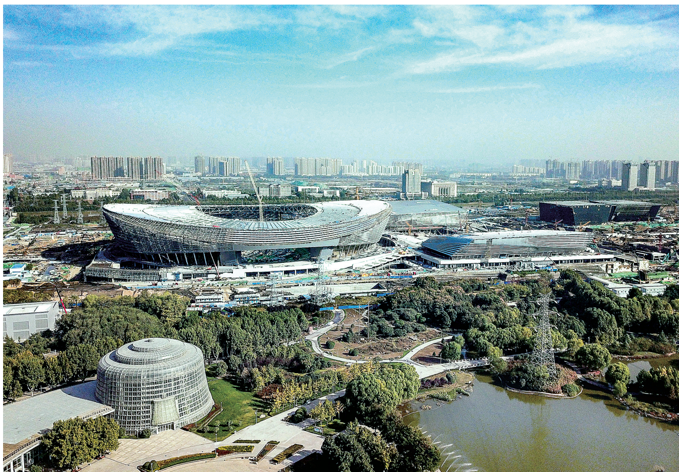
郑州西区最令人瞩目的建设——奥林匹克体育中心、文博艺术中心、市民活动中心、现代传媒中心,目前正有序推进,很多建筑的主体结构 and 钢结构已完工,正在进行楼体外立面和内部结构施工,郑州中央文化区正在向我们走来。图为昨日记者拍摄的植物园北侧奥体中心。记者 马健 图
