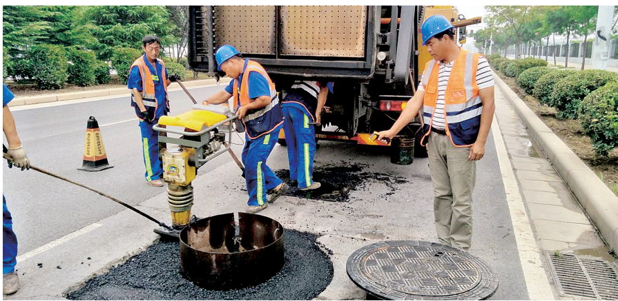
技术人员安装防沉降井盖
