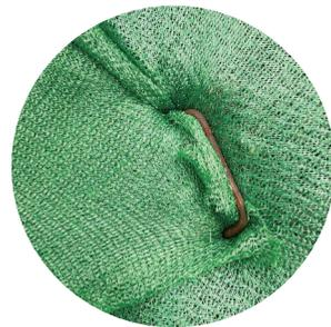
用规定型号的钢筋加固防尘网连接处
