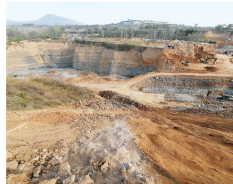
覆盖。常庄安置区A地块经查该项目未施工,现场覆盖良好。
