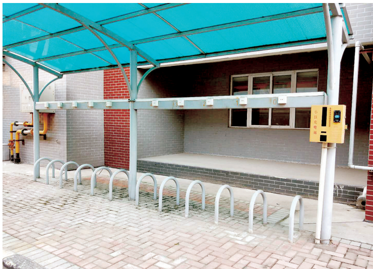
公租房楼下的电动车充电棚
