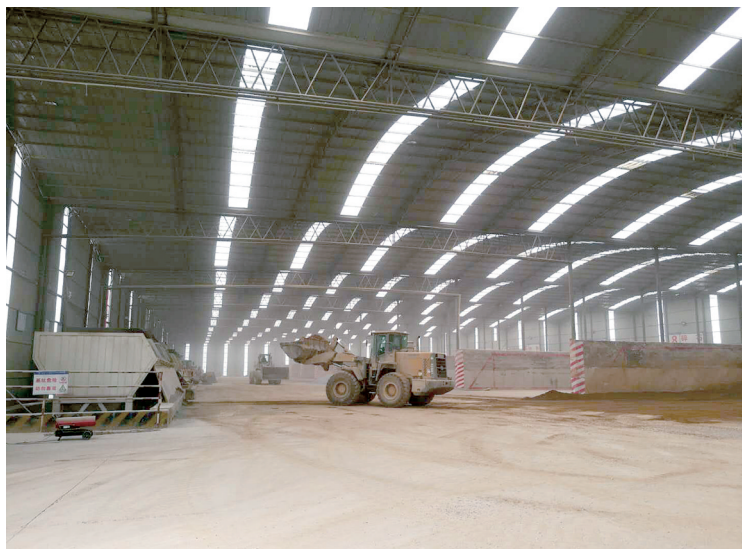
中铁十六局郑州南站1号混凝土搅拌站
