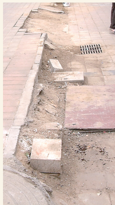
破损的路板
