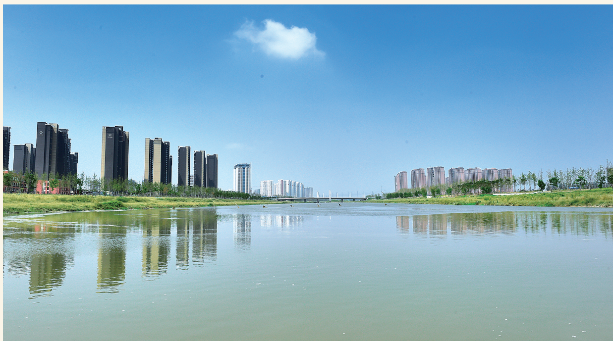
贾鲁河综合治理工程正在全力推进 记者 王秀清 图
