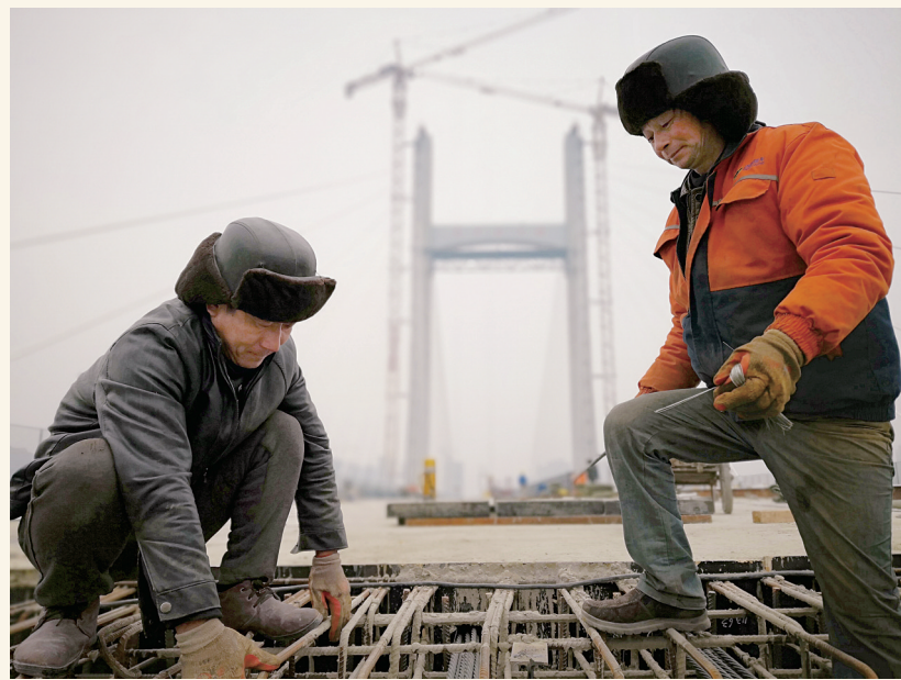
两名钢筋工正在施工
