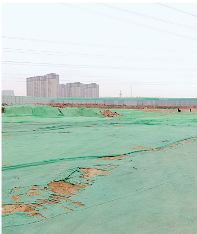
现场督查后，裸露黄土被覆盖
