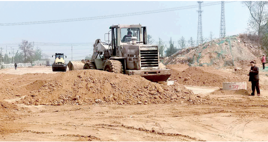
郑风大道道路工程,年限过期推土车仍在用
