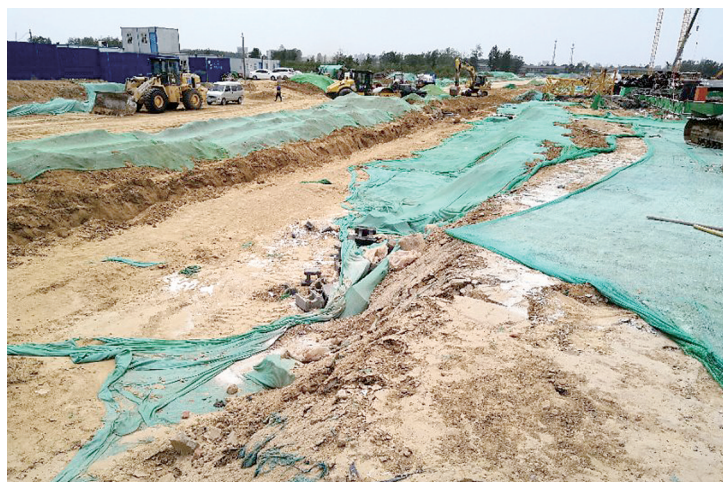
航空港区工业六路道路工程工地
