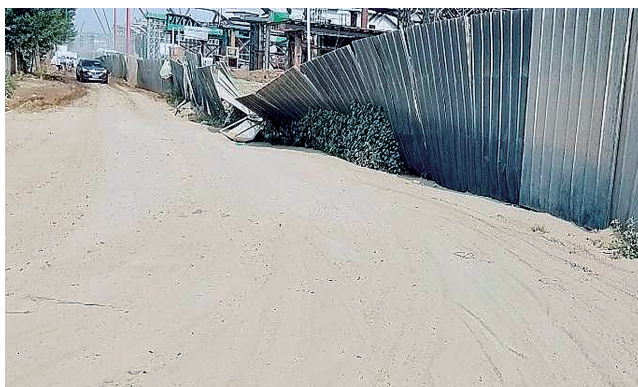
惠济区四环线工地
