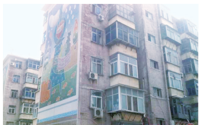
外立面整治前
