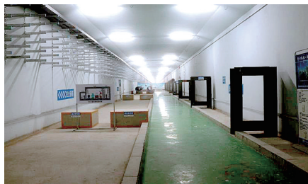
地下管廊工地现场
