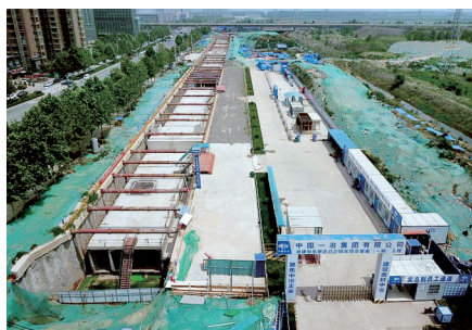
郑东新区白沙园区综合管廊(一期)工程主管廊基本贯通
