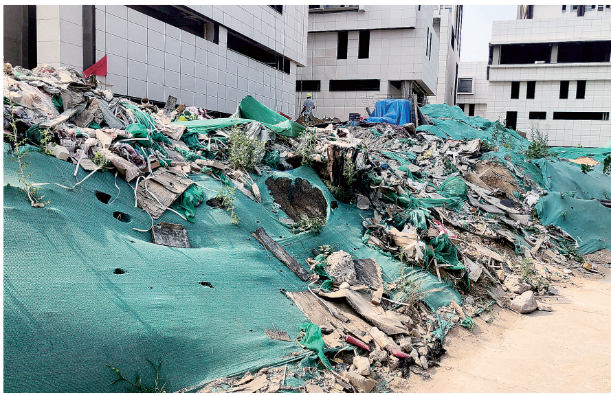
石佛艺术公社基地项目建筑垃圾覆盖不到位
