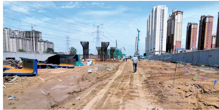
国道310线郑州西南段改建工程SG02标段
