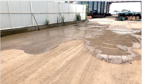
郑州至巩义市域铁路市政配套工程土建施工02标段
