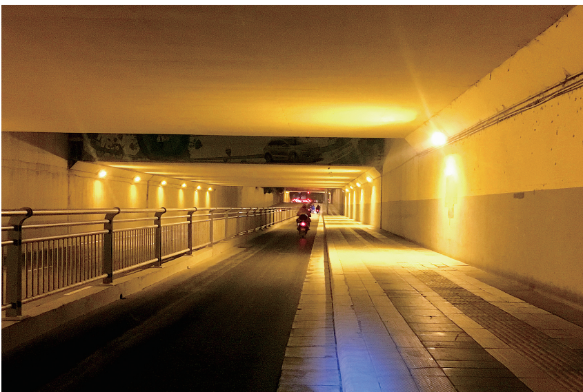
北三环(南阳路—电厂路)立交下穿道路恢复亮灯
