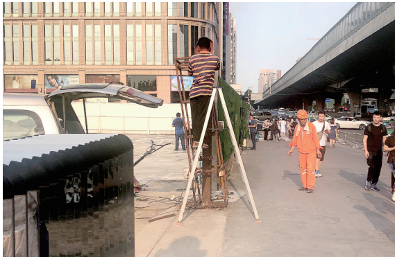
农业路花园路口西北角围挡拆除
