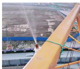
据项目安全和扬尘负责人王武江介绍,从立项开始,该项目就严格按照“8个%”施工。现场围挡均高于3米,主干道位置围挡高度达到5米,底部均设置防溢座;在前期土方作业阶段,保证100%湿法作业,雾炮、喷淋、塔吊喷淋全部工作。现在,每两个小时开启喷淋1小时。土方作业秉承着“边干边盖”原则,保证裸露黄土仅限于工作面,停止土方作业时保证黄土100%覆盖;场区道路全部水泥硬化,且每天上午和下午上下班各洒水一次,遇到雾霾天气或者高温天气,加大洒水次数。渣土运输保证车辆100%封闭,出入车辆100%冲洗干净,冲洗设备保证随时工作状态,此外还对基坑外围主干道长久存留的黄土进行了种草绿化。
