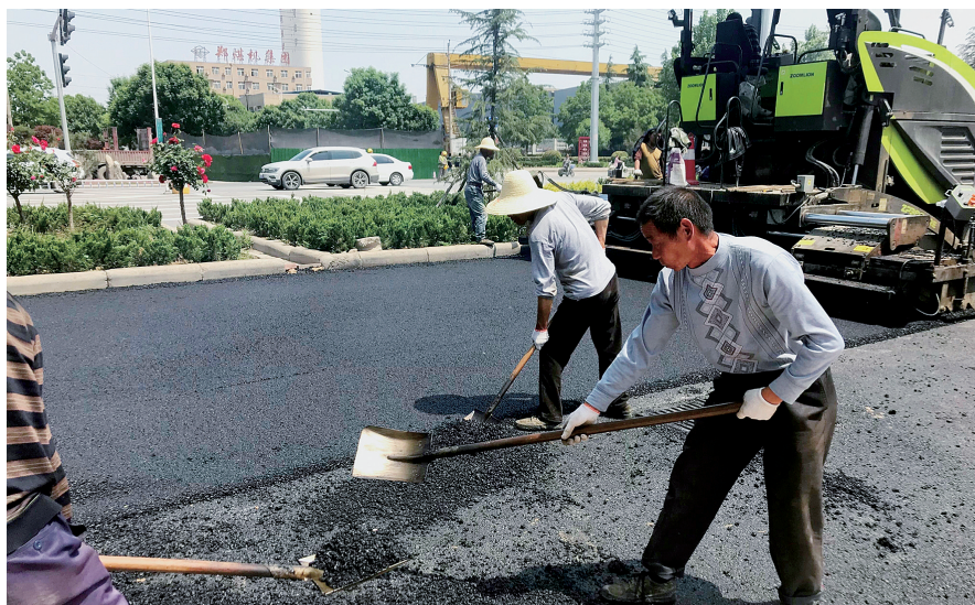
施工中的飞龙路
