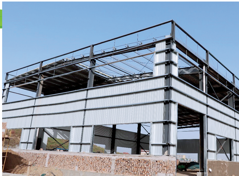
正在建设中的生活垃圾分拣中心
