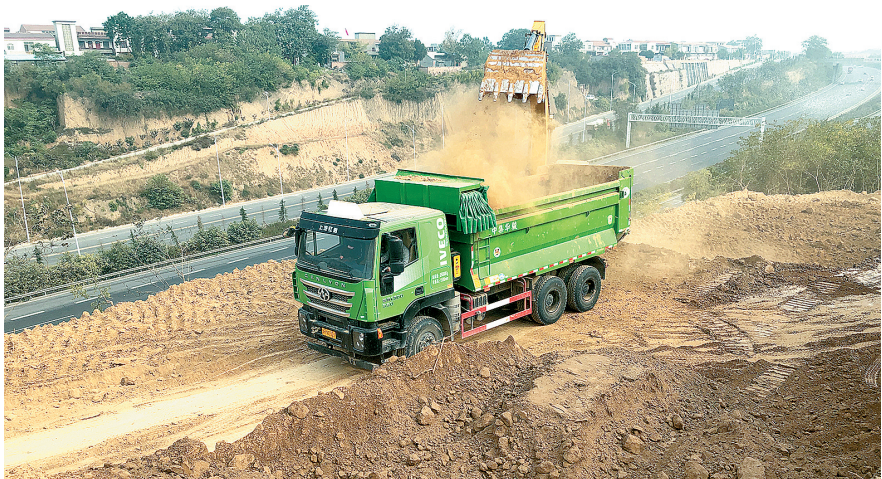
巩义生态廊道连霍高速北窑湾标段项目工地
