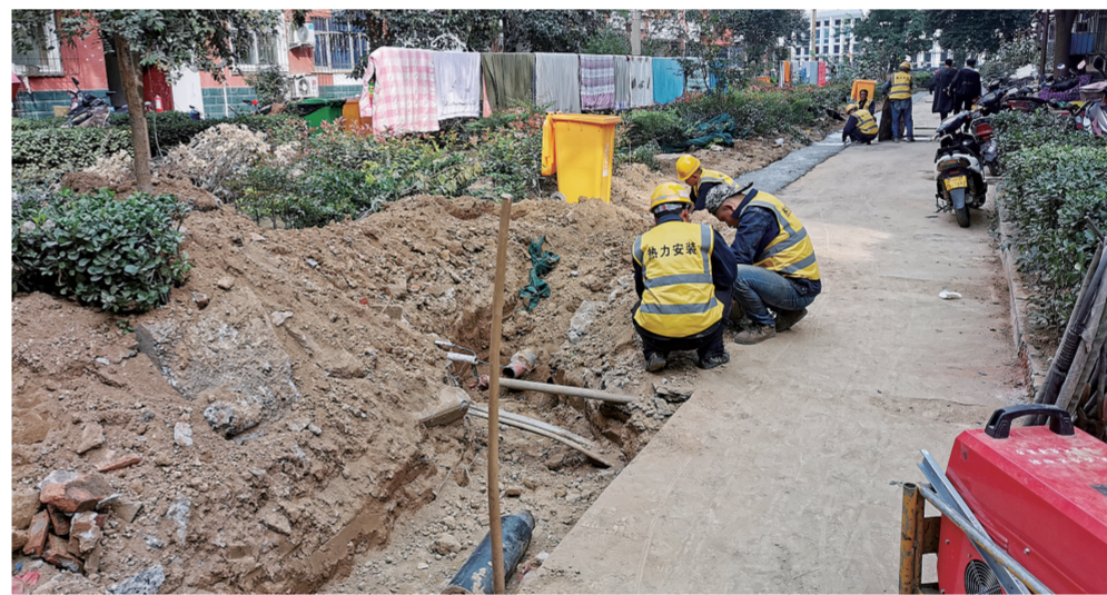
暖气施工时的场景
