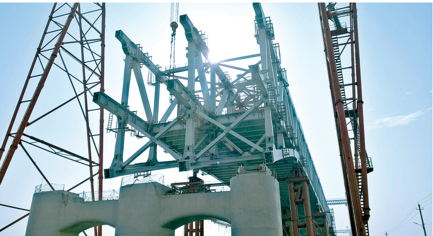
建设中的郑济铁路郑州黄河特大桥
