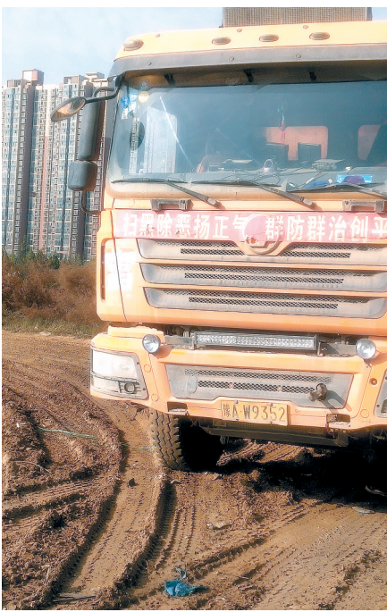
前程大道与美辰路交叉口一无名工地
