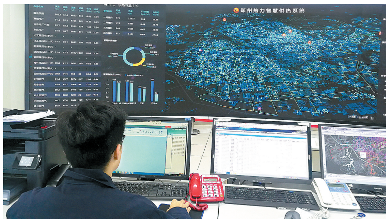
供热公司人员在监控全市供热情况
