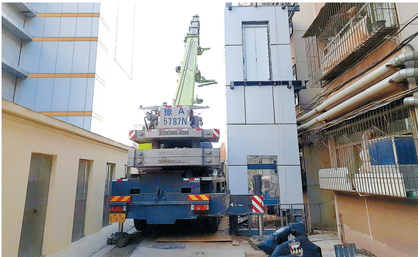
宇通家属院再次加装电梯动工
