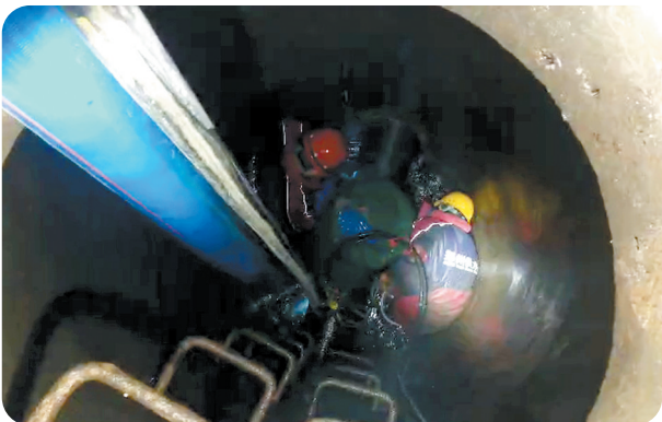
郑州自来水抢修人员维修供水闸阀 郑报全媒体记者 张华 图
