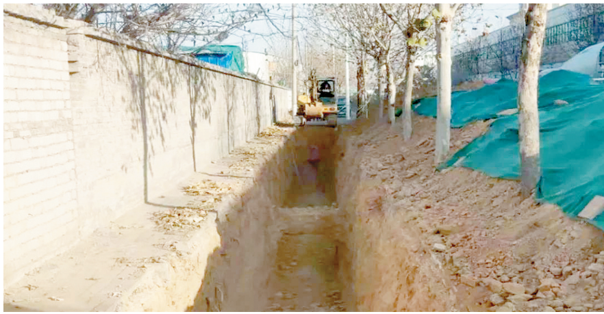
马寨集中供热项目主管网日前建设现场
