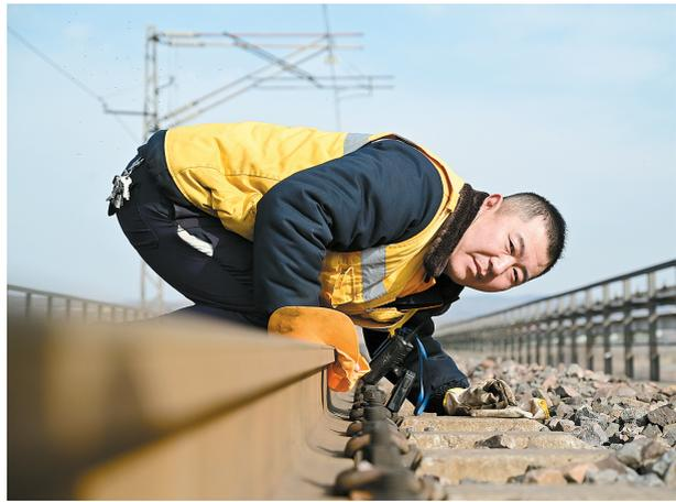
杨春城跪在冰冷的钢轨上检查钢轨平顺度
