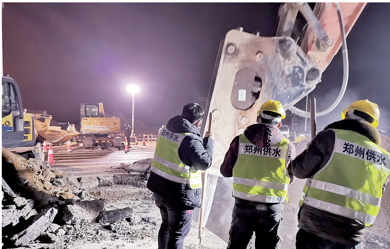
郑州供水人奋战在岐伯山医院供水管线铺设工地
