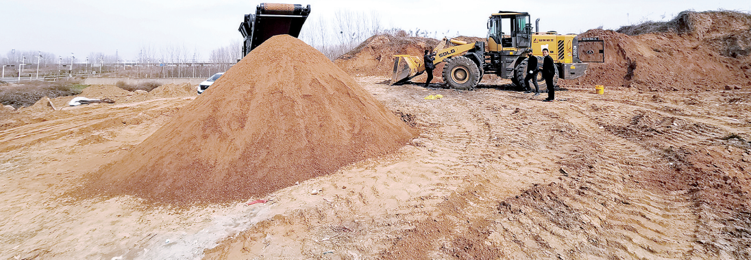
航空港区学院路与京港澳高速交叉口西南300米
