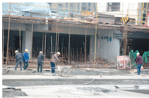
民生工程复工
