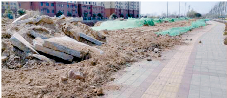
金水科教园区金宝路绿化工地
