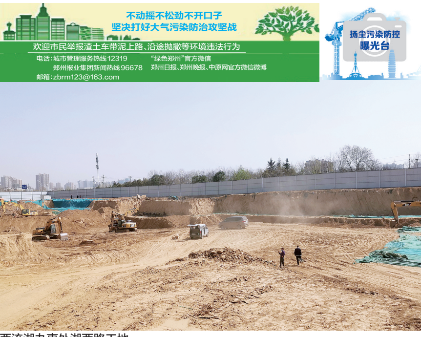
西流湖办事处湖西路工地
