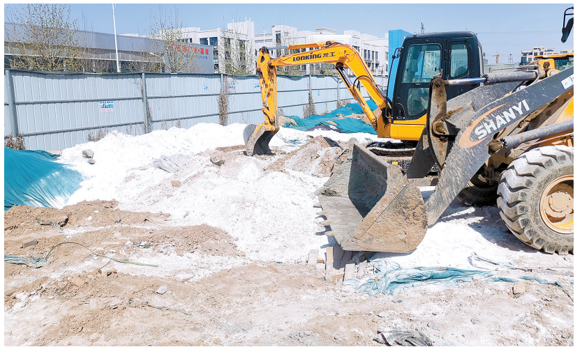
迅宏置业标准化厂房建设工地
