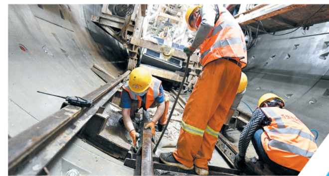
6号线土建05标临冯区间电瓶车轨道安装
