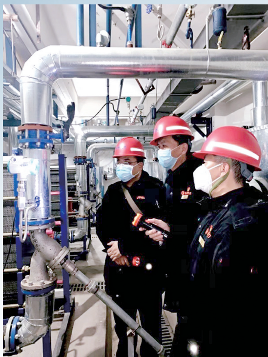
工作人员检修热力管道
