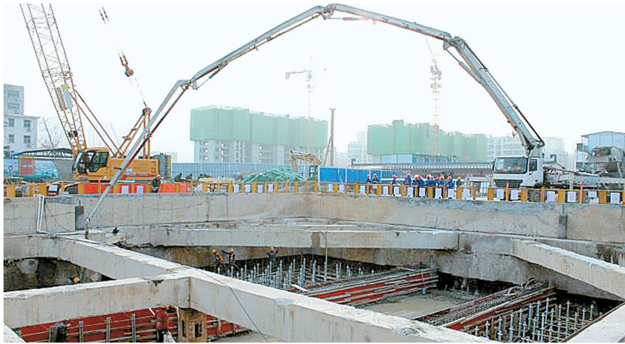
在下一步工作中,中铁十一局将持续提升项目管理水平,精心筹划、科学组织,确保桐淮站附属结构施工及市中心医院站主体施工再上新台阶。 记者 张改华 通讯员 高庆 卢凯 文/图
