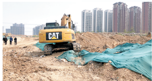
湖悦澜庭项目工地
