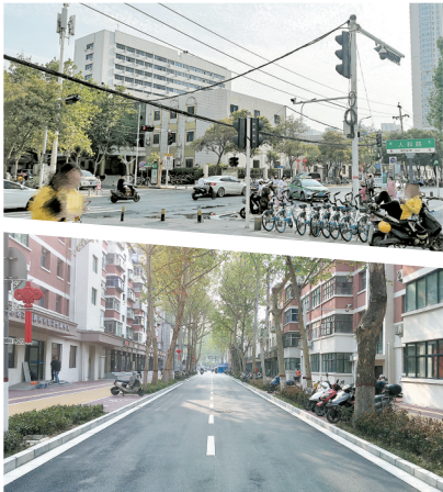
人和路通信线缆改造前后
