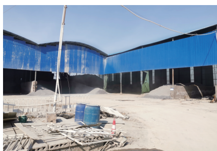
S312郑州境改建工程5标配套拌合站
