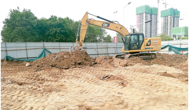
龙门路(花园路—中州大道)道路工程项目
