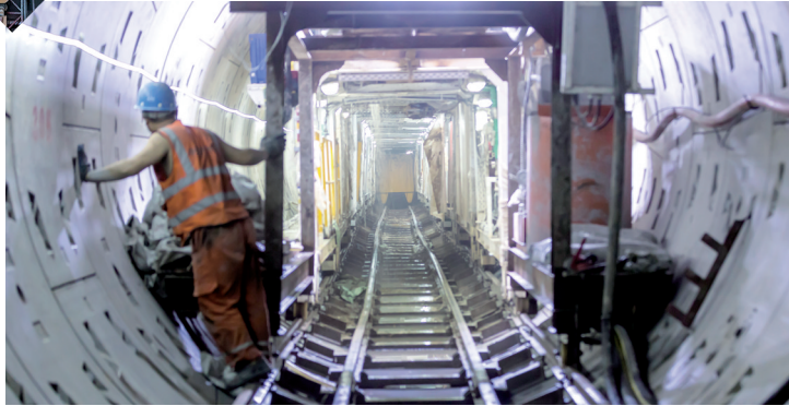
工人在电力隧道内检修
